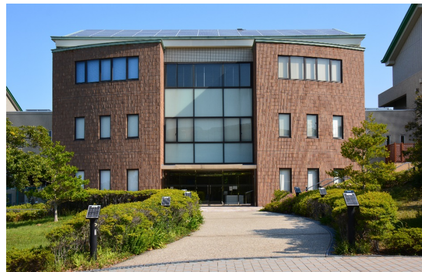
《 附属図書館棟（正面） 》
