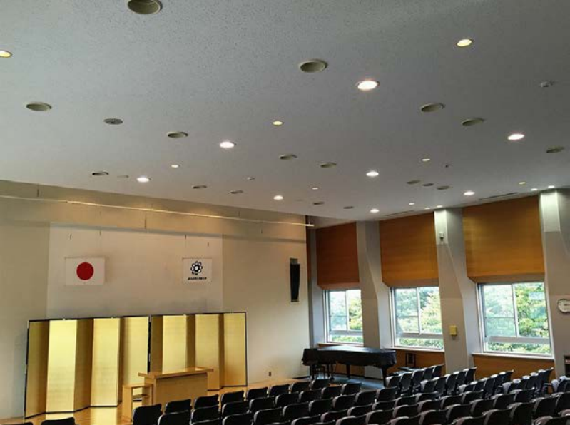
《 共通棟大講義室（天井耐震化工事後） 》
