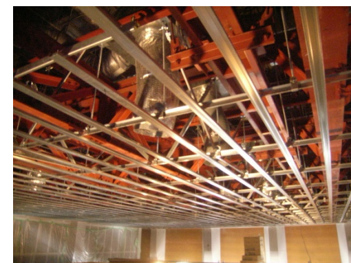
《 構造天井を構築している様子 》
