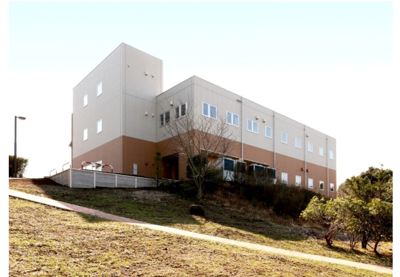
《 学融合推進センター棟（北面） 》
